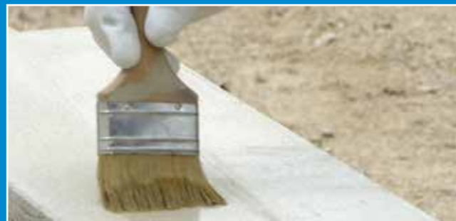
felület előkészítése a tömítésre
