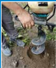
Alapgödör kialakítása
