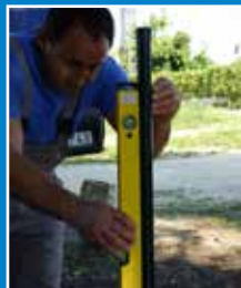
Oszlop függőbe állítása
