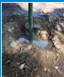
Megkötött anyag utónedvesítése
